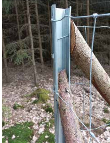
Vzpěry se umísťují jen na lomové body nebo k vstupním brankám. Uchycení vzpěr se řeší samořeznými vruty.
